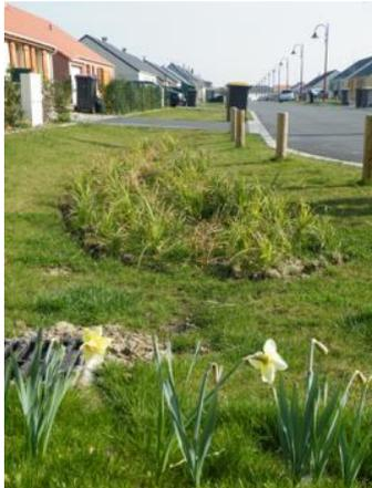
*Les noues : ouvrages de rétention / infiltration des eaux pluviales*
