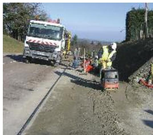
Les derniers travaux du projet de réhabilitation du centre bourg, concernant la rue St Martin de Tours, ont abouti. Ils ont permis de créer un réseau d'assainissement séparatif avec un renforcement du réseau d'eau potable ainsi que l'enfouissement des réseaux de télécommunication, d'électricité et de l'éclairage public avec la pose de candélabres. Le coût total est de 122 000 € HT, subventionné à hauteur de 80 000 € HT, par le Conseil Général.
